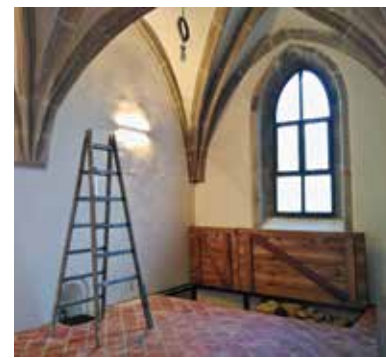
Sakristie kostela Všech svatých na Roudné je po požáru už opravena.
